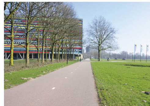
5. Percorso in asfalto colorato senza cordolatura. Uitof, Utrecht (Olanda)
