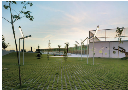
1. Parcheggio a verde con grigliato carrabile Luis Manzanares Avenue , Torre Pacheco (Spain)
