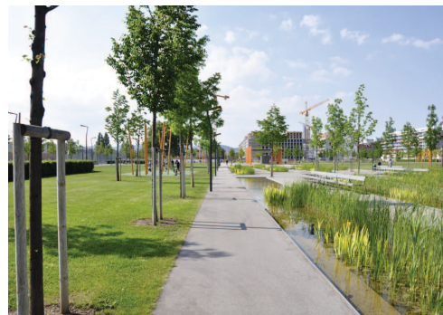
4. Percorso in asfalto con cordolo su un lato in ferro zincato. Rudolf Bednar Park, Vienna (Austria)
