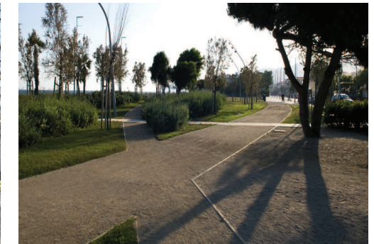
3. Percorso in terra stabilizzata con cordoli in legno. Pista ciclopedonale Barcellona (Spagna)
