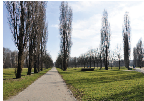
1. Percorso in terra stabilizzata con cordoli in cemento a raso. Parco Nord, Milano (Italia)
