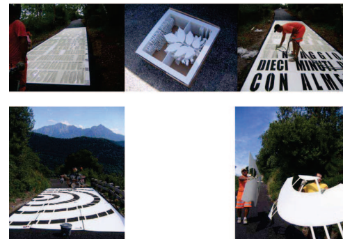
5. Dime per realizzazione grafica colorata su superficie in asfalto. Sormano, Como (Italia)
