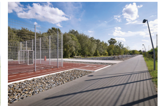
6. Percorso in asfalto senza cordolatura. Vienna (Austria)
