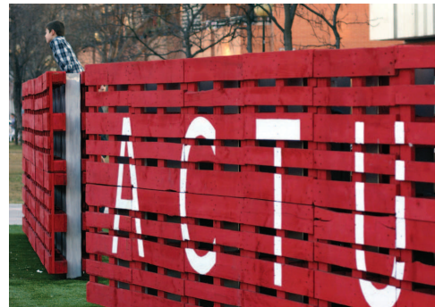
2. Recinzione in pallets. Progetto Estonoesunsolar, Saragozza (Spagna)
